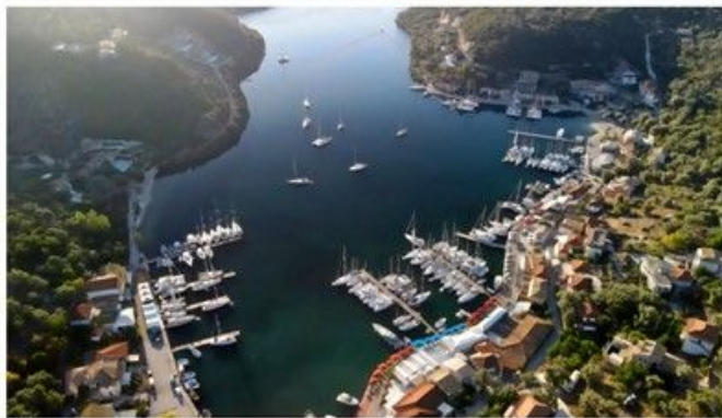
Vom einfachen Hafen zum voll ausgebauten Stegangebot mit Wasser und Strom.
