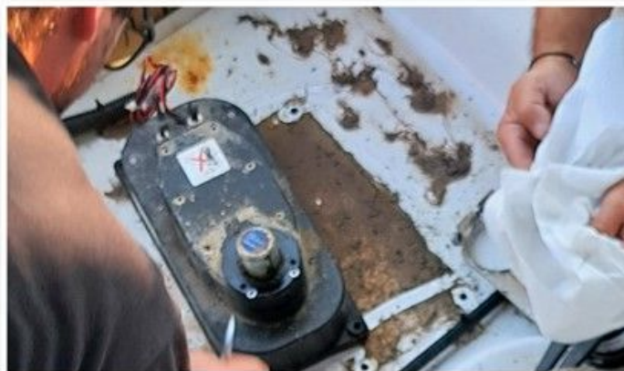
Der Motor des Autopilot wird ausgewechselt.
