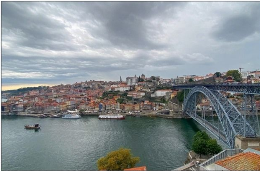
Eine hundertjährige Stahlbrücke verbindet die zwei Stadtteile von Porto. Das obere Trasse wird von der U-Bahn befahren, unten fahren die Autos.
