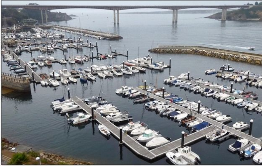
Die Marina von Ribadeo mit ihrer 30 m hohen Brücke. Durchfahrt nur beim linken Pfeiler!
